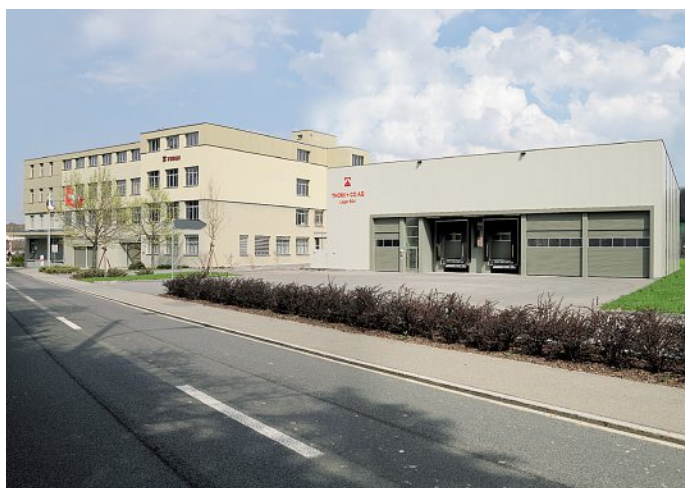
Stabile principale e magazzino. Quest'ultimo è collegato allo stabile principale tramite un corridoio sotterraneo.
