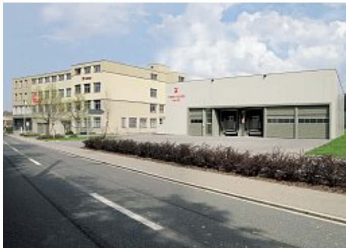
Immeuble commercial et d'entrepôt. Ce dernier est relié au bâtiment principal par un passage sous-terrain.
